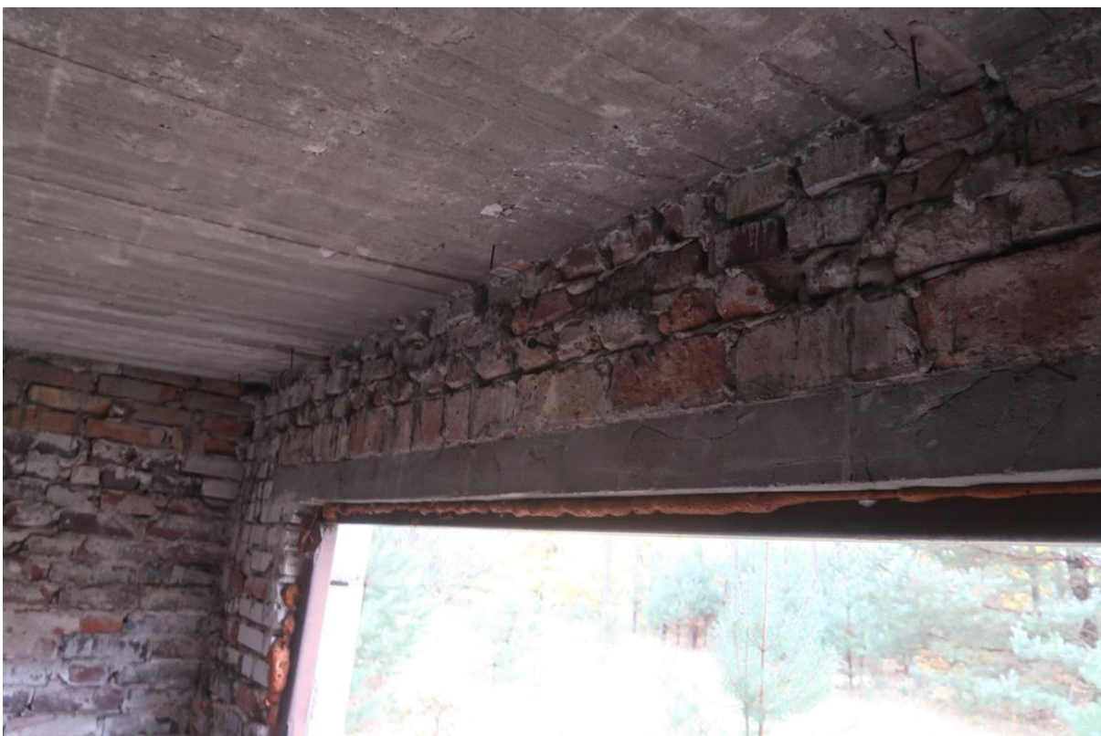
Fot. 19. Widoczne nadproże i erozja cegieł oraz zaprawy powyżej otworu drzwiowego na zachodniej elewacji.
