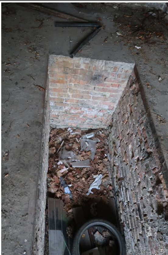
Fot. 12. Murowane ściany kanału technicznego. Widoczne ubytki cegły i zaprawy.
