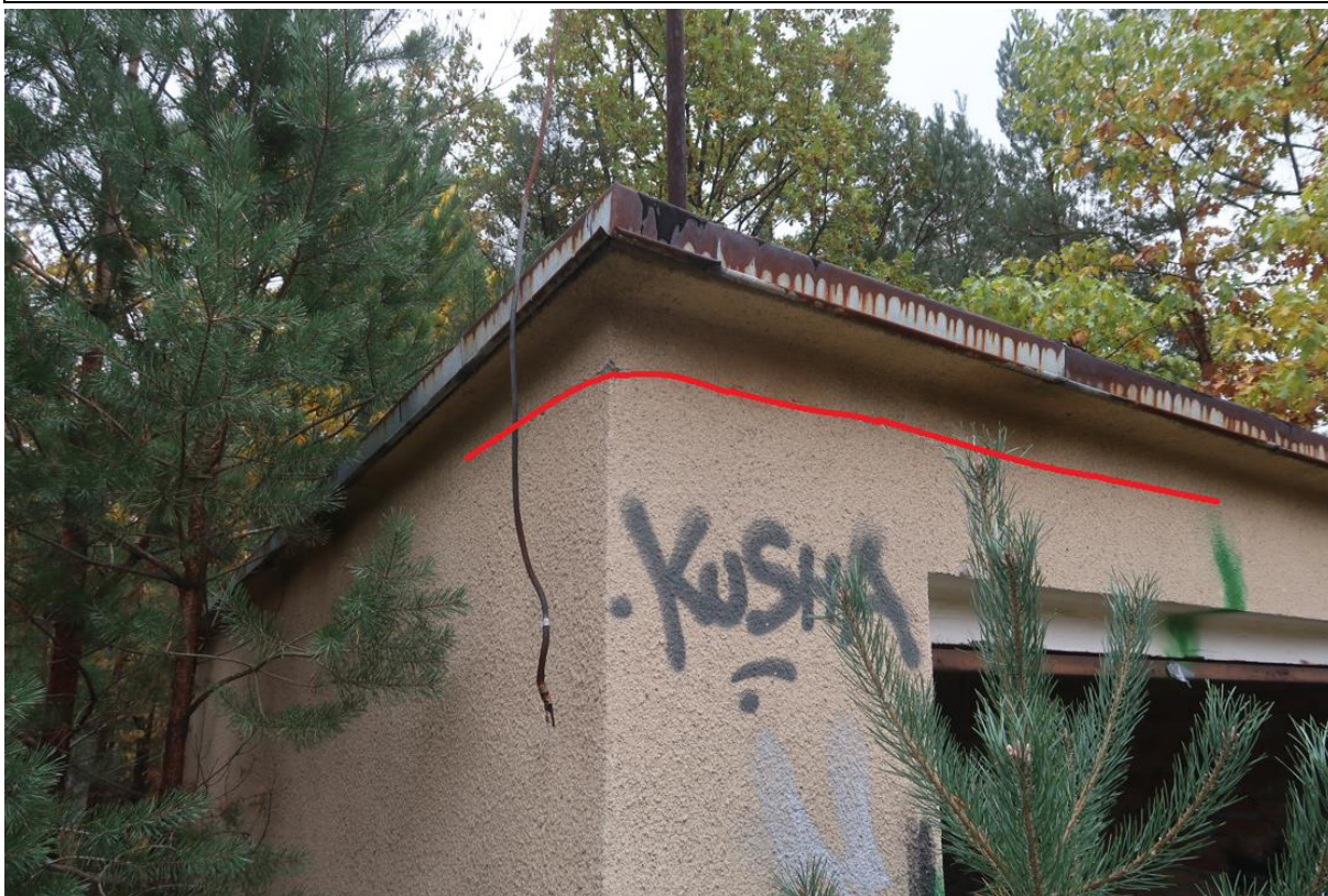
Fot. 8. Zarysowanie poziome na zachodniej i północnej elewacji w miejscu oparcia płyty żelbetowej na murze.
