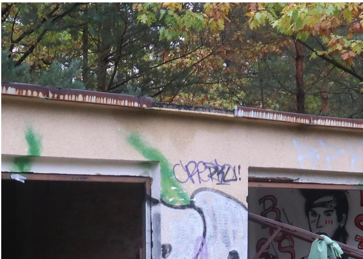
Fot. 31. Korozja obróbek blacharskich w poziomie stropodachu. Widoczne ubytki obróbki blacharskiej.
