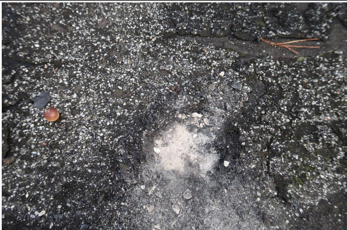
Fot. 21. Odkrywka O.7 warstw stropodachu. W odkrywce stwierdzono pokrycie z dwóch warstw papy na lepiku wykonane bezpośrednio na płycie żelbetowej. Papa jest popękana, w złym stanie technicznym.
