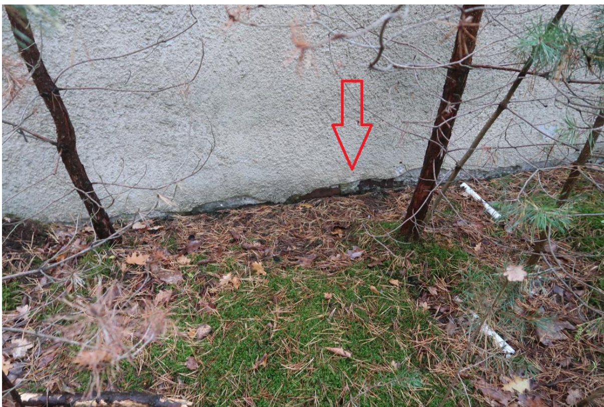
Fot. 9. Odparzony tynk w poziomie terenu na północnej elewacji.
