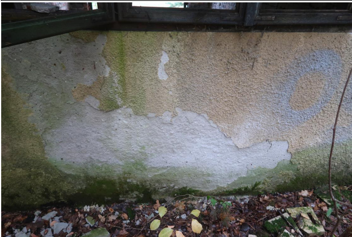
Fot. 10. Odparzony tynk na wschodniej elewacji.
