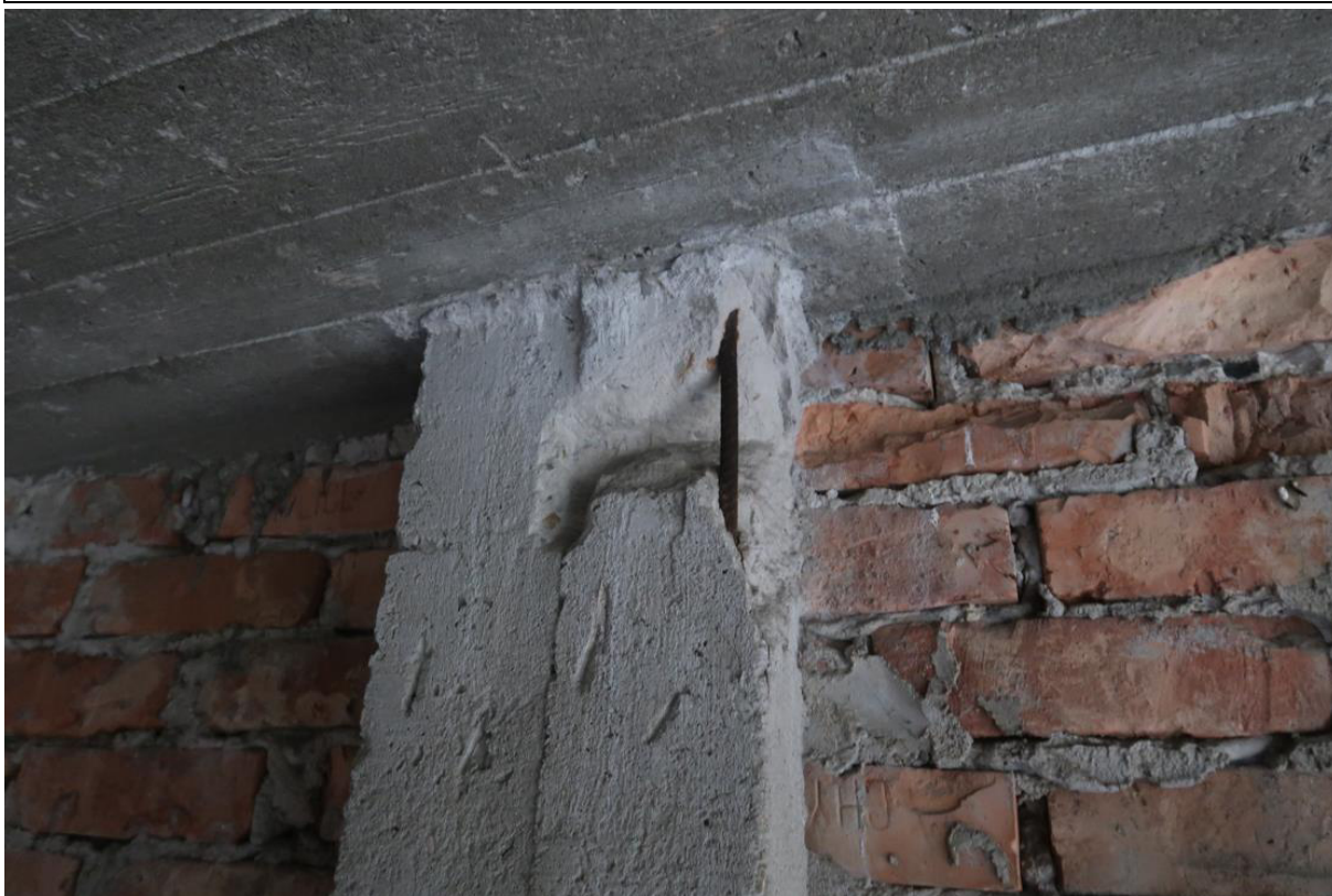
Fot. 15. Odparzona otulina zbrojenia w słupie i skorodowane zbrojenie w górnej części słupa. Widoczny ślad po zdemontowanej instalacji.
