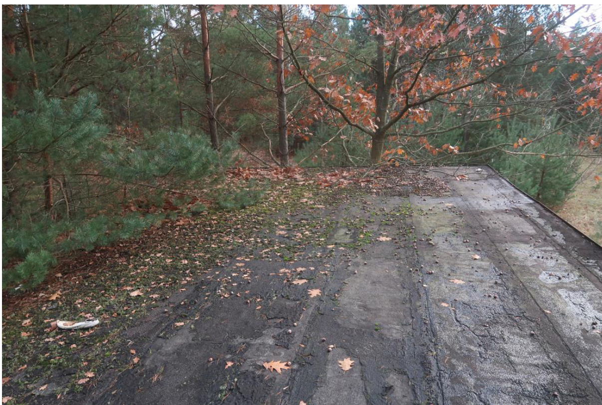
Fot. 24. Stropodach pokryty papą. Widoczne zużycie pokrycia z papy oraz zalegające liście i gałęzie na stropodachu.
