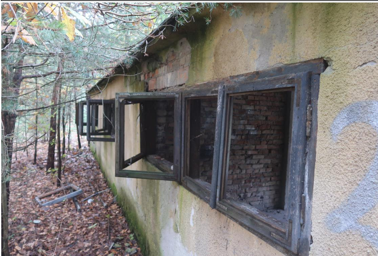
Fot. 29. Uszkodzona i zużyta drewniana stolarka okienna .
