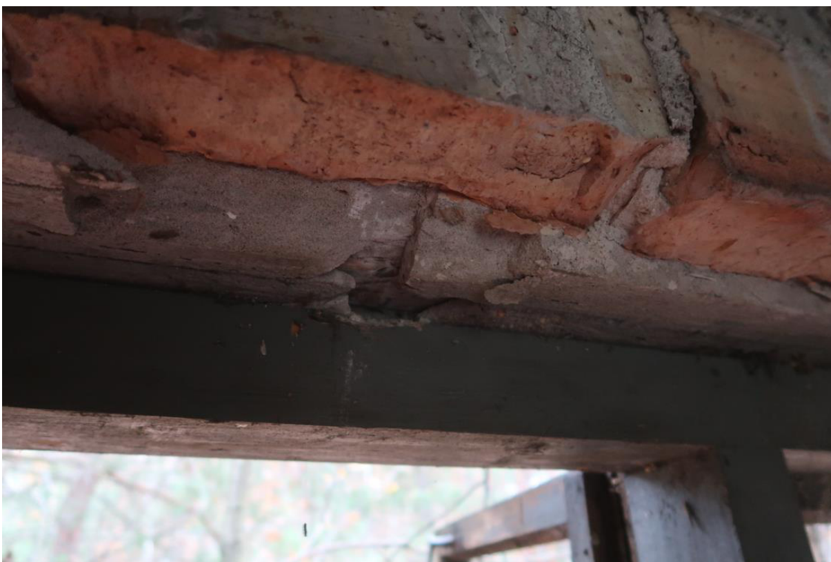
Fot. 17. Odkrywka O.2 nadproża. Stwierdzono nadproże z belki stalowej wykonanej z dwuteownika IPN100, skorodowanego powierzchniowo.
