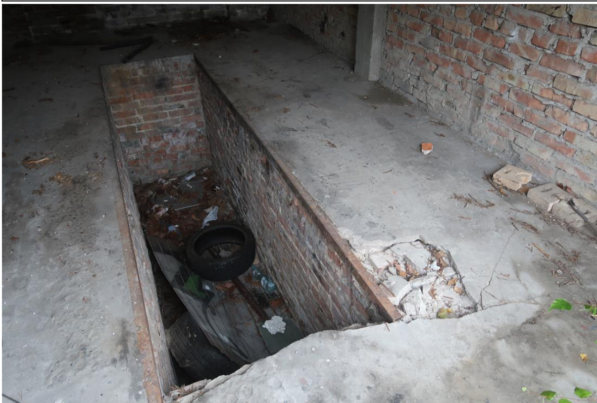
Fot. 28. Skruszona posadzka betonowa przy kanale technicznym.
