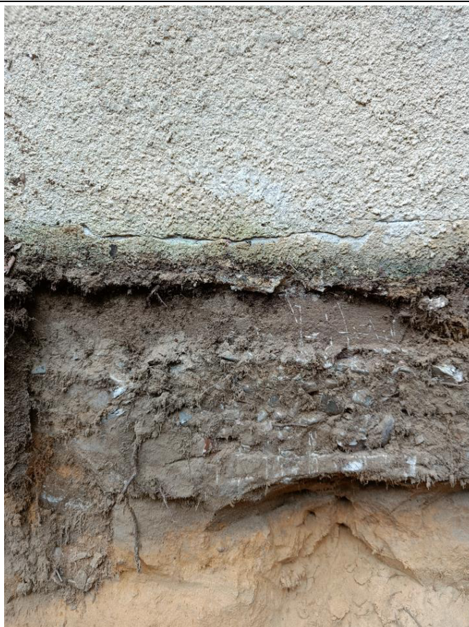
Fot. 6. Odkrywka F.1. fundamentów. W wykonanej odkrywce stwierdzono ławę gruzobetonową bez odsadzki o grubości 20cm. Fundament posadowiony jest około 30cm p.p.t.
