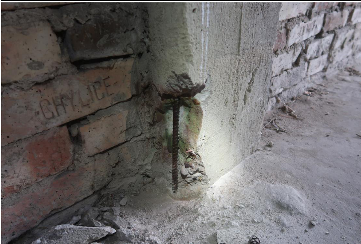
Fot. 13. Odkrywka O.6 słupa. W odkrywce stwierdzono słup żelbetowy o przekroju 25x25cm, zbrojony podłużnie prętami żebrowanymi 4#12, strzemiona \phi 6 . Otulina zbrojenia wynosi 15÷30mm. Lokalnie otulina jest odparzona, a zbrojenie skorodowane powierzchniowo. Występuje karbonatyzacja betonu.
