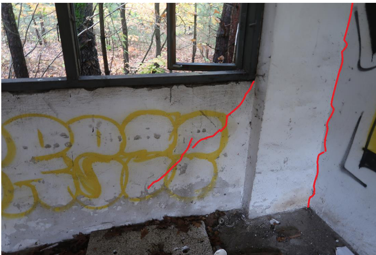
Fot. 11. Zarysowanie skośne ściany podokiennej i pionowe zarysowanie w narożu ściany w środkowym pomieszczeniu. Widoczna również odparzona powłoka malarska / tynk na ścianie podokiennej.
