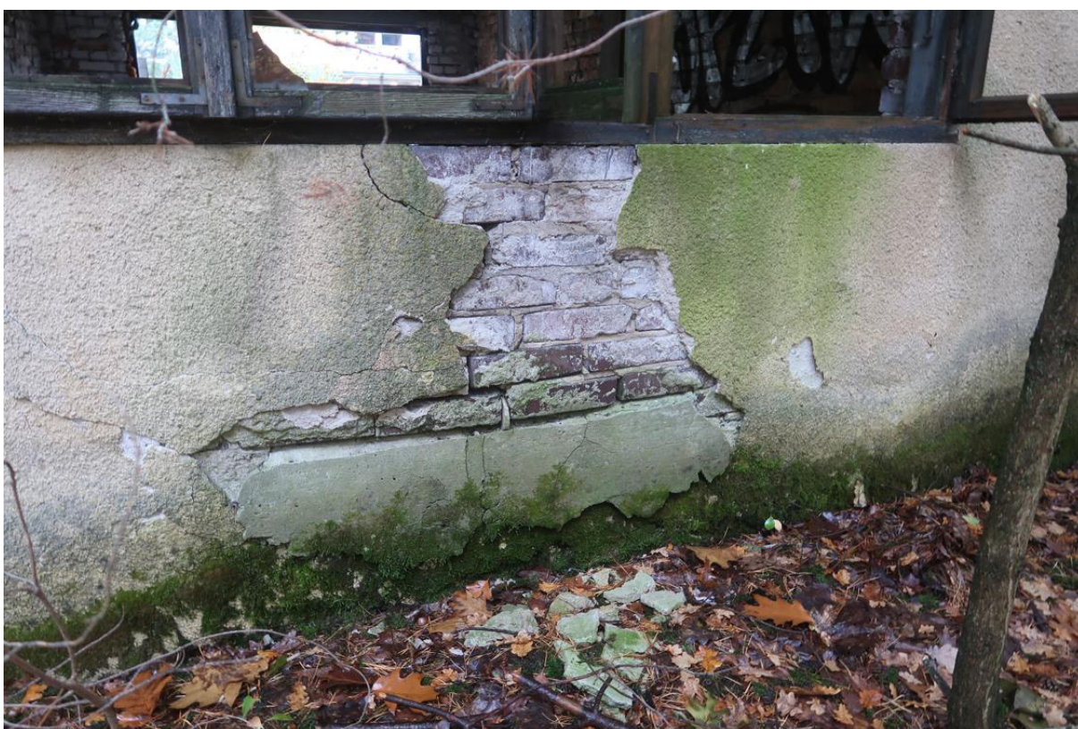
Fot. 7. Odparzony tynk i widoczne zagłonicie w miejscu wypchniętego muru na wschodniej elewacji.
