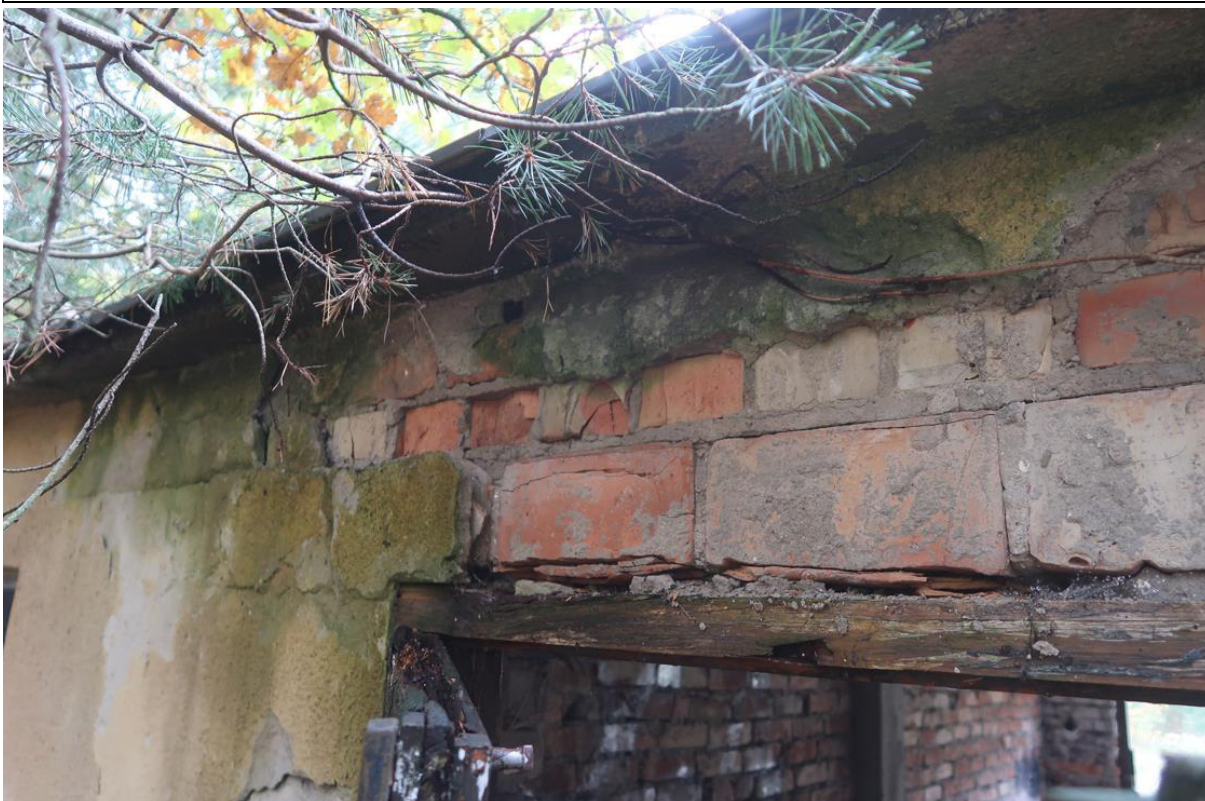
Fot. 18. Odparzony tynk na nadprożu na wschodniej elewacji. Widoczne erozja wierzchniej warstwy cegieł i korozja biologiczna elementów stolarki.
