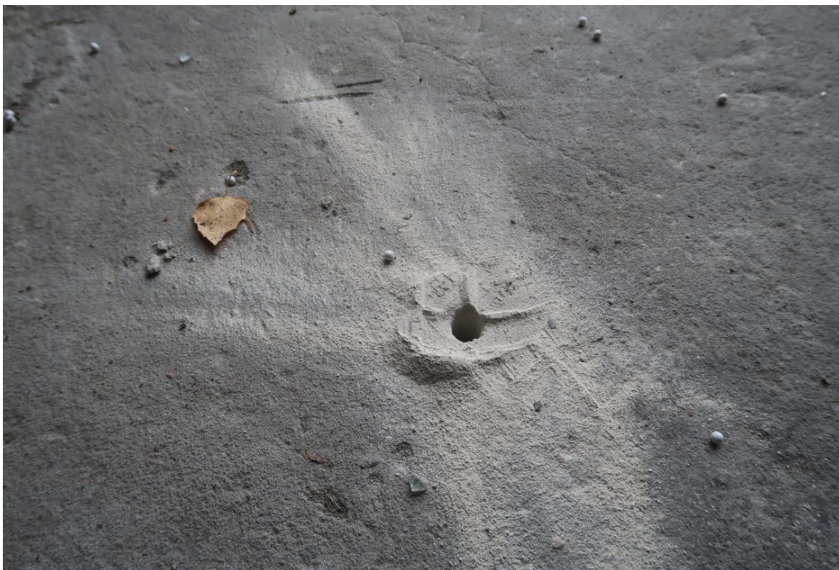
Fot. 25. Odkrywka O.4 posadzki. Stwierdzono płytę betonową gr. 11cm na podsypce piaskowej.
