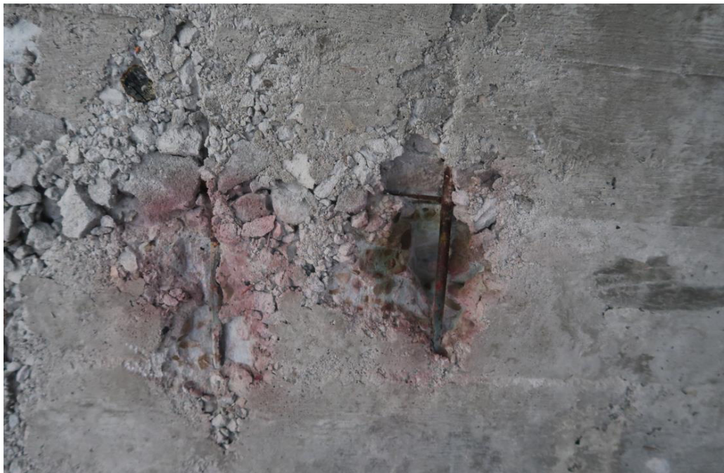
Fot. 20. Odkrywka O.1 płyty stropodachu. W odkrywce stwierdzono płytę zbrojoną prętami gładkimi \varnothing 8 w rozstawie co 15÷17cm. Otulina zbrojenia wynosi 10÷15mm. Lokalnie otulina jest odparzona, a zbrojenie skorodowane powierzchniowo. Występuje karbonatyzacja betonu.
