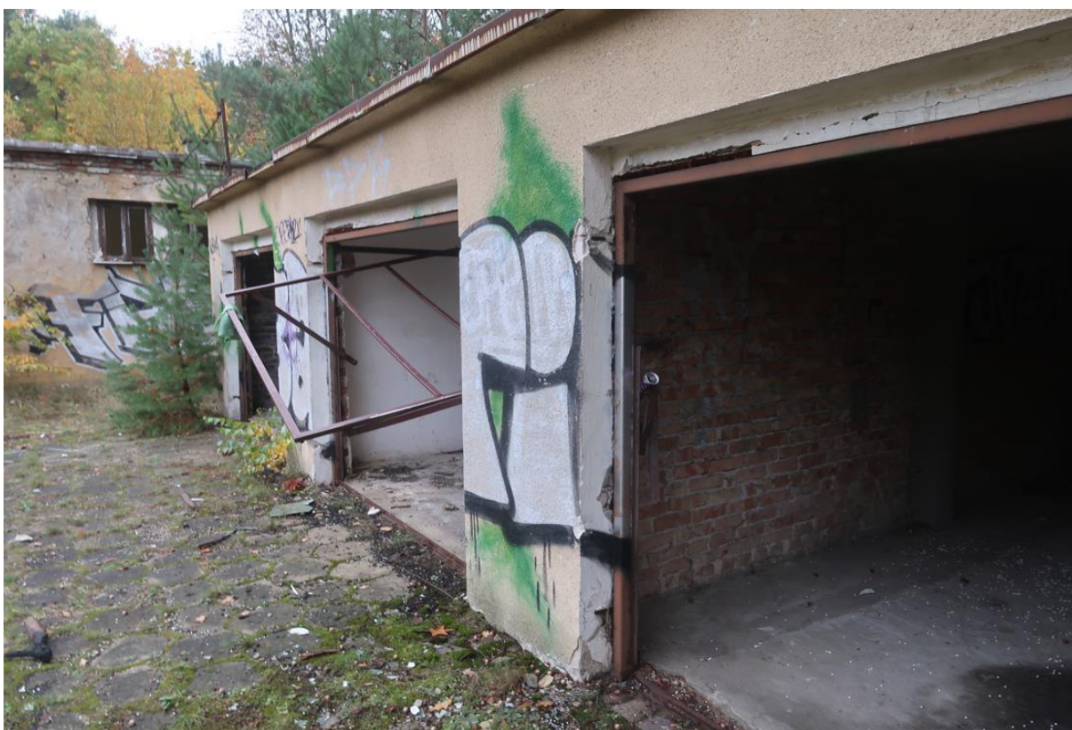
Fot. 30. Zdemontowana stalowa stolarka drzwiowa. Widoczne pozostałości elementów stalowych.
