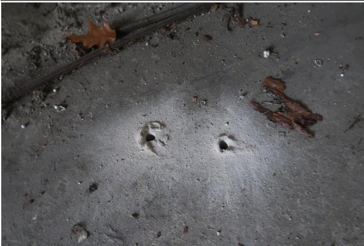
Fot. 26. Odkrywka O.5 posadzki. Stwierdzono płytę betonową gr. 8cm na podsypce piaskowej.
