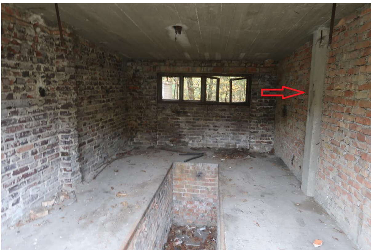
Fot. 14. Po prawej stronie w pomieszczeniu widoczny słup żelbetowy. W ścianie zewnętrznej (lewa strona) występuje pilaster murowany. W słupie stwierdzono odparzoną otulinę zbrojenia.
