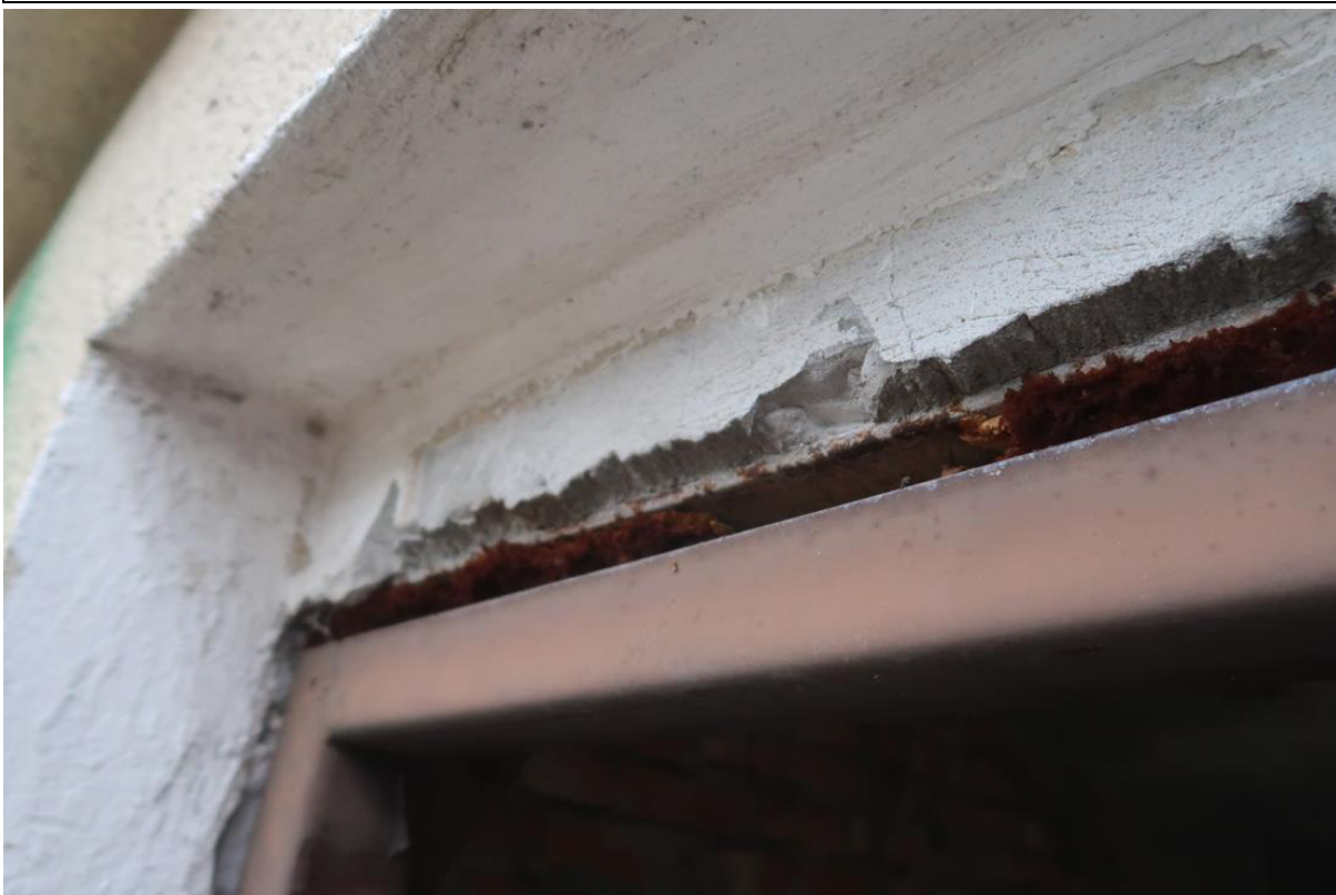
Fot. 16. Odkrywka O.2 nadproża. Stwierdzono nadproże z belki stalowej wykonanej z dwuteownika IPN100, skorodowanego powierzchniowo.
