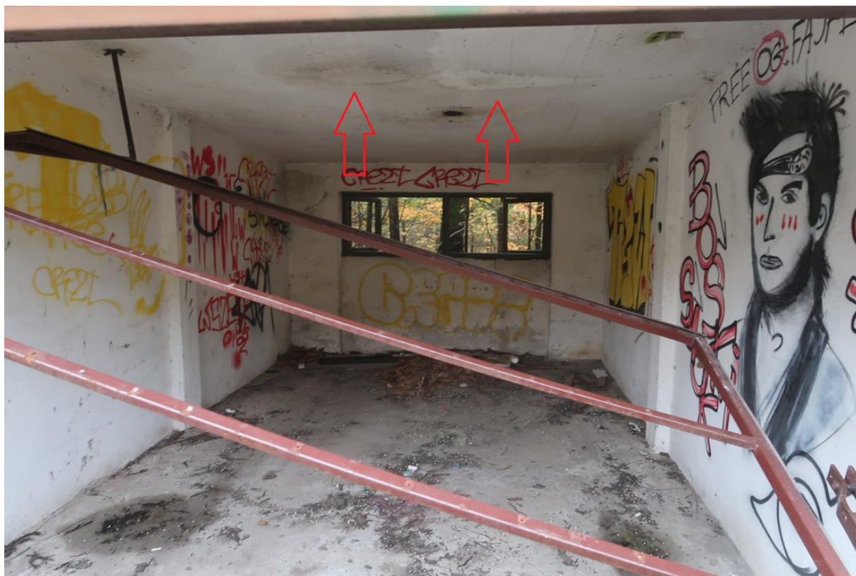
Fot. 22. Ślady po zaciekach na spodzie stropu w środkowym pomieszczeniu, które jest otynkowane.
